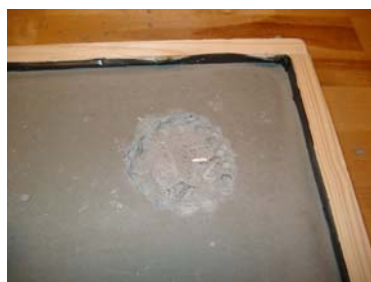
Bild 4: Ytan jämnas av och dammsugs
