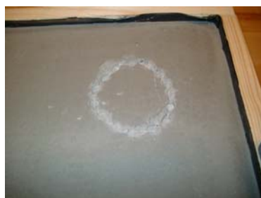
Bild 2: Hålen bilas till en cirkel
